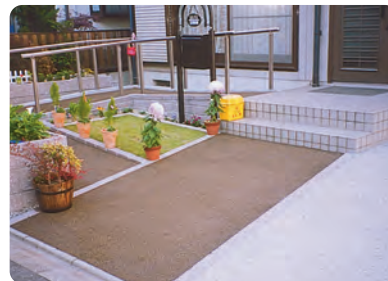
玄関にスロープを設置
